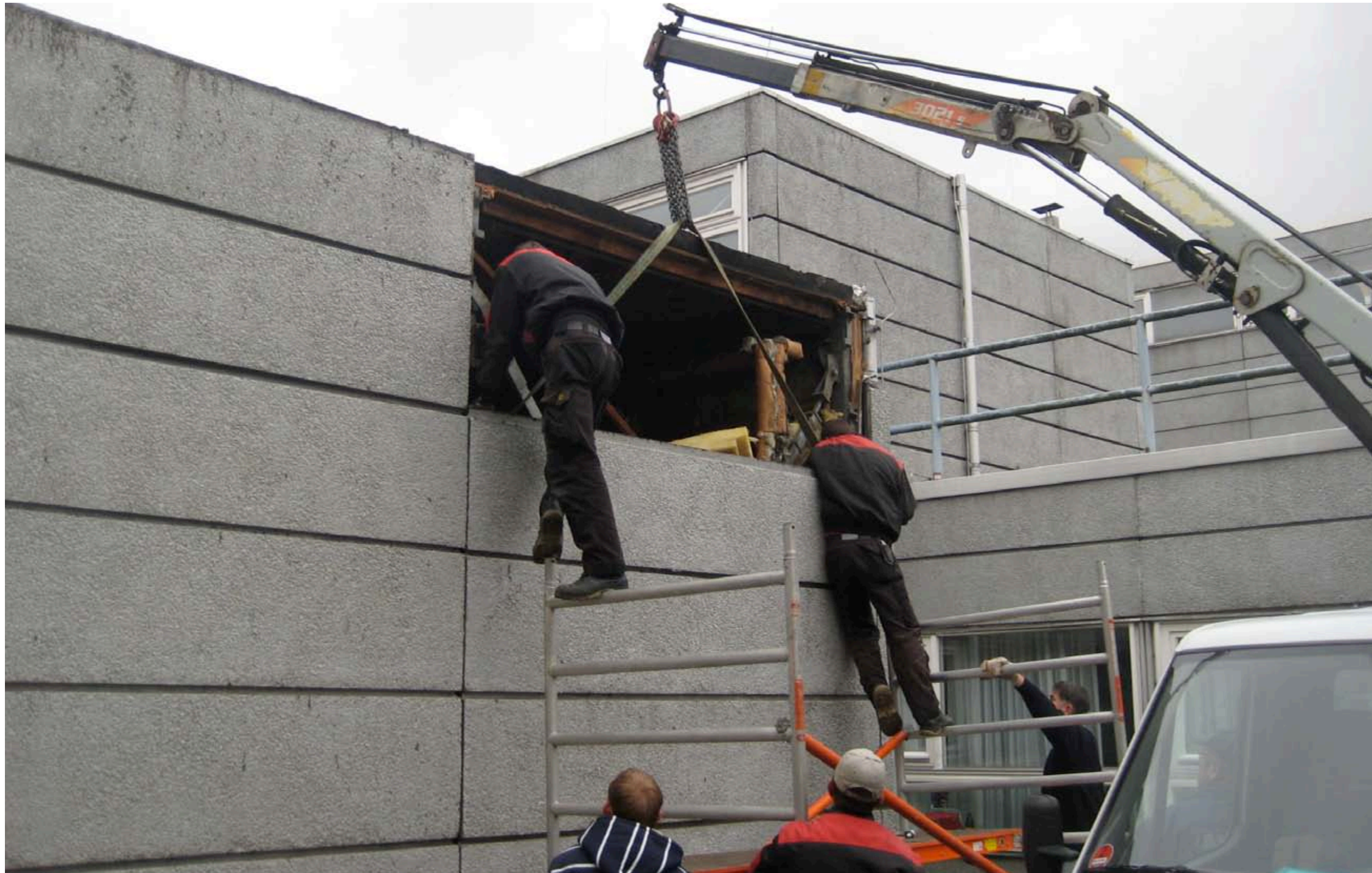
Fassade wird wieder geschlossen
