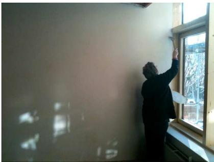
Lasieren begonnen, Zwischendecken angepasst, Heizkörper gereinigt, Pflastersteine umgestapelt... Dank der fleißigen Helfer und Helferinnen konnten alle Restflächen hinter den Heizkörpern in den beiden Türmen gestrichen werden, sodass Anfang nächster Woche in diesen Räumen die restlichen Heizkörper montiert und die Türme ab Mittwoch wieder beheizt werden können. Die angeschafften Radiatoren können dann in den zweigeschossigen Querriegel
