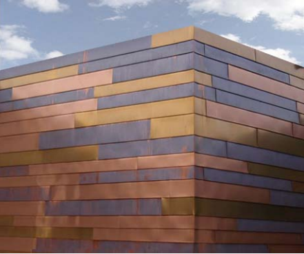
Beispiel Kupferfassade mit Stehfalz in verschiedenen Kupferlegierungen
